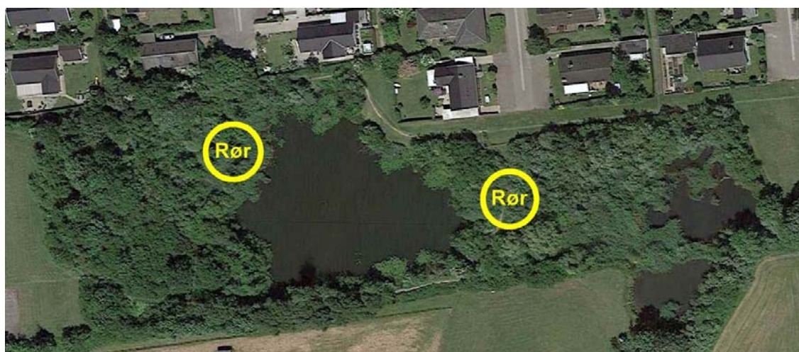
Figure 9. Rørføring til udskiftning
