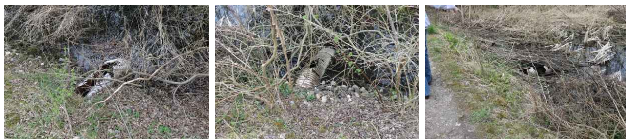
Figure 4. Ødelagte rør
